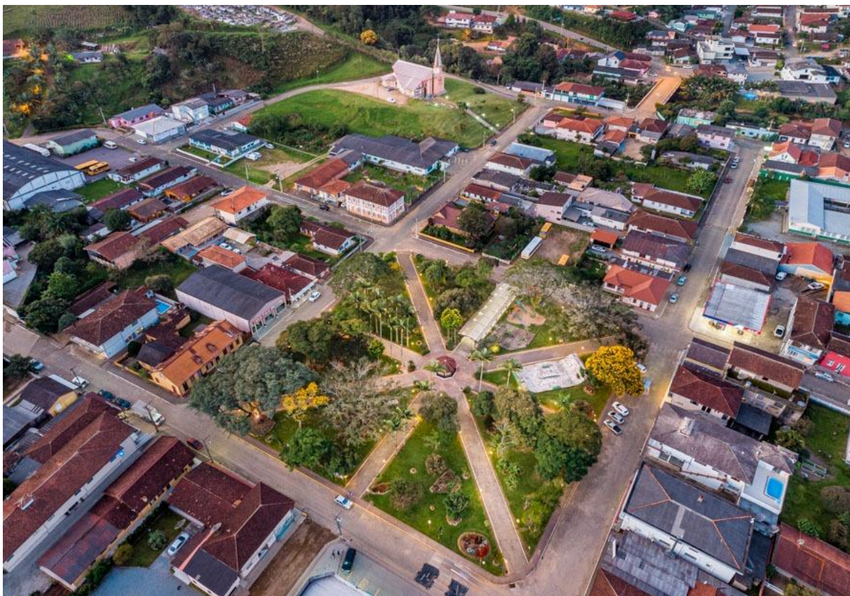
Figura 15. Núcleo Central de Anitápolis
