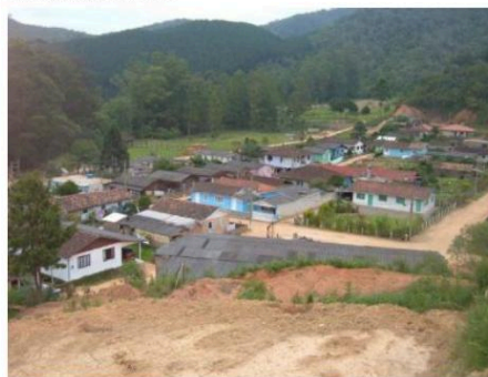
LOTEAMENTO VILA ANTÔNIO DAVID – SITUAÇÃO EM 2006 Fonte: Acervo Sílvia Maia, 2007
