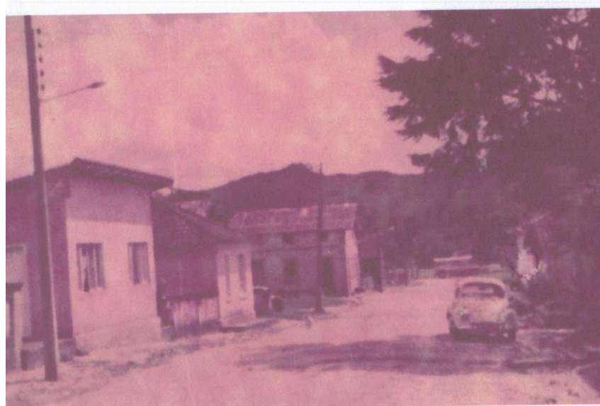
TELHADO DE ZINCO DA ANTIGA CASA E LATERAL ESQUERDA APENAS COM SÓTÃO BAIXO E NÃO SEGUNDO PISO COMO ATUAL
