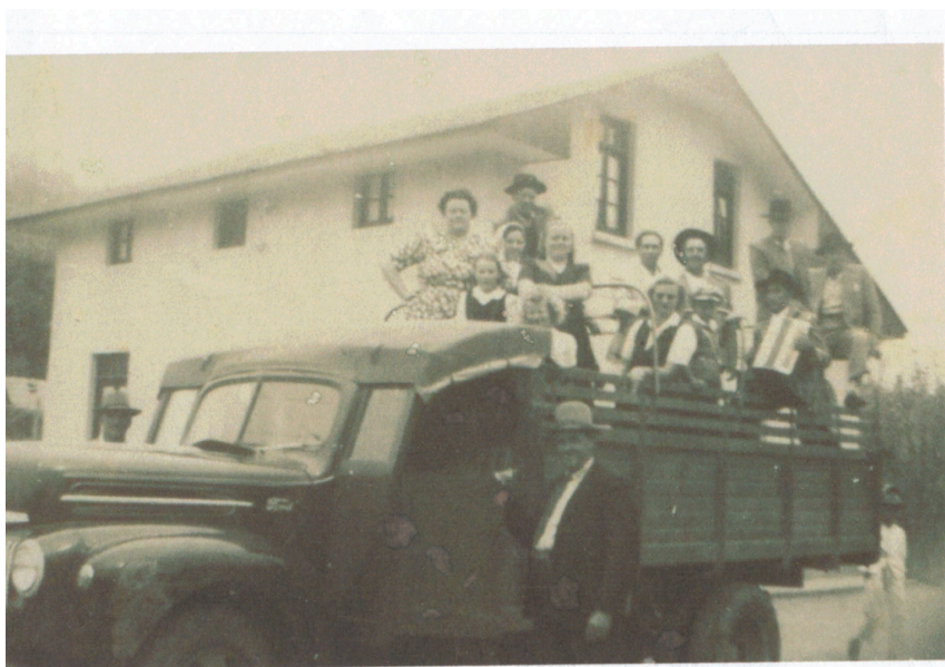
LATERAL ESQUERDA E FALTA DA CASA ANTIGA
