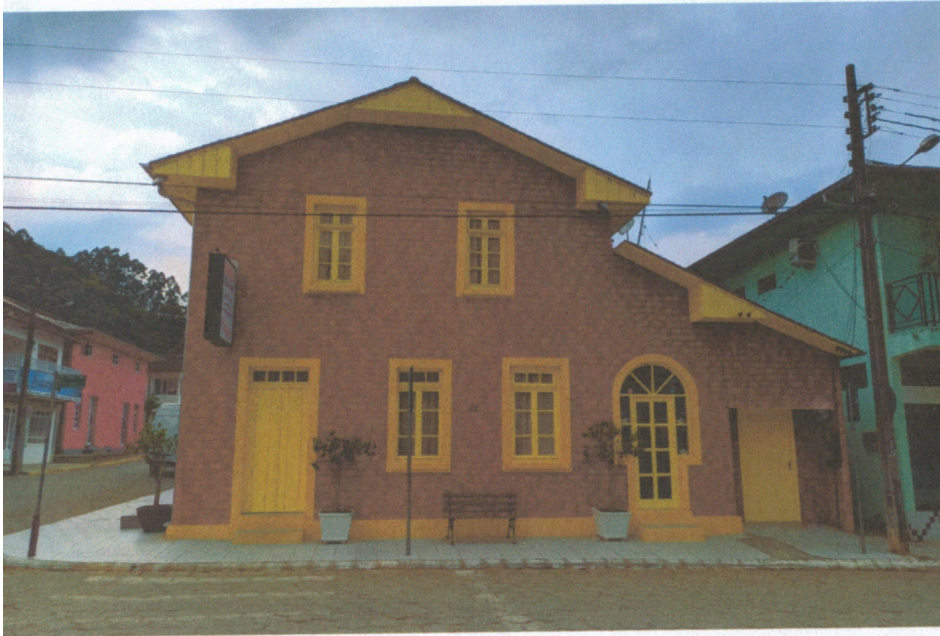
FACIADA DA CASA NOVA AGORA COM 2 PAVIMENTOS E TELHAS DE BARRO
