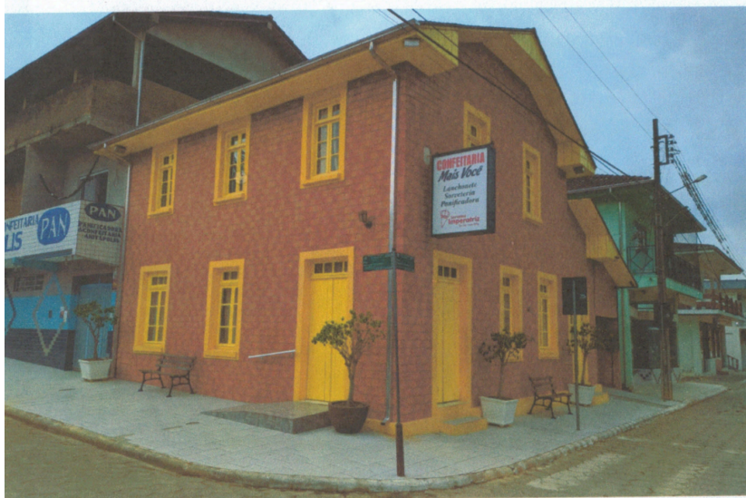
LATERAL ESQUERDA E FACIADA DO NOVO PRÉDIO COM PISO CERÂMICO NAS PARQUES E ACOPADO AO PRÉDIO DE 3 PAVIMENTOS DO QUAL A CASA NOVA FAZ PARTE
